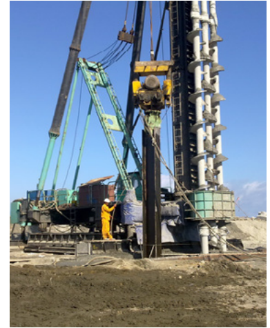
取水箱涵SMW施工
