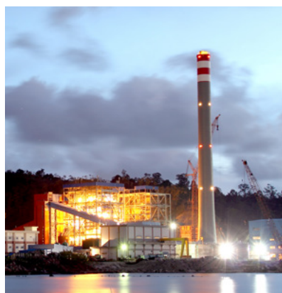
印度尼西亚西苏2×112MW燃煤电站项目
