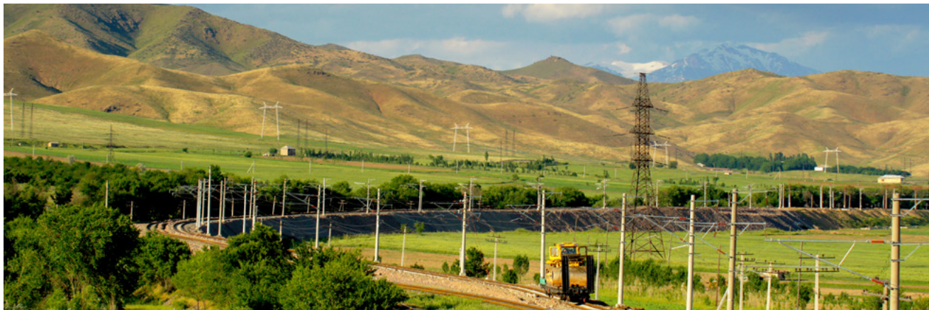
乌兹别克斯坦铁路电气化项目
