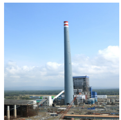
印度尼西亚阿迪帕拉1×660MW超临界燃煤电站项目
