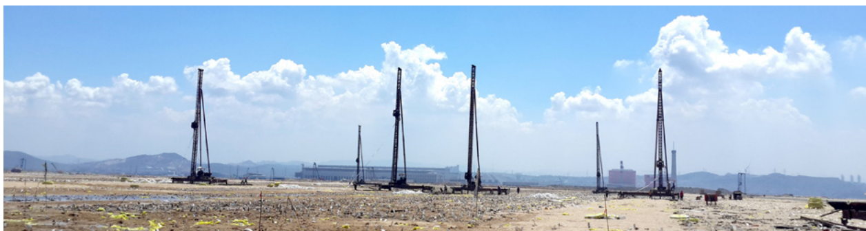
塑料排水板施工
