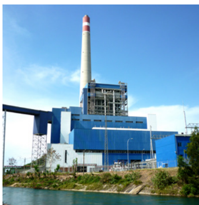
印度尼西亚苏娜拉亚1×625MW燃煤电站项目
