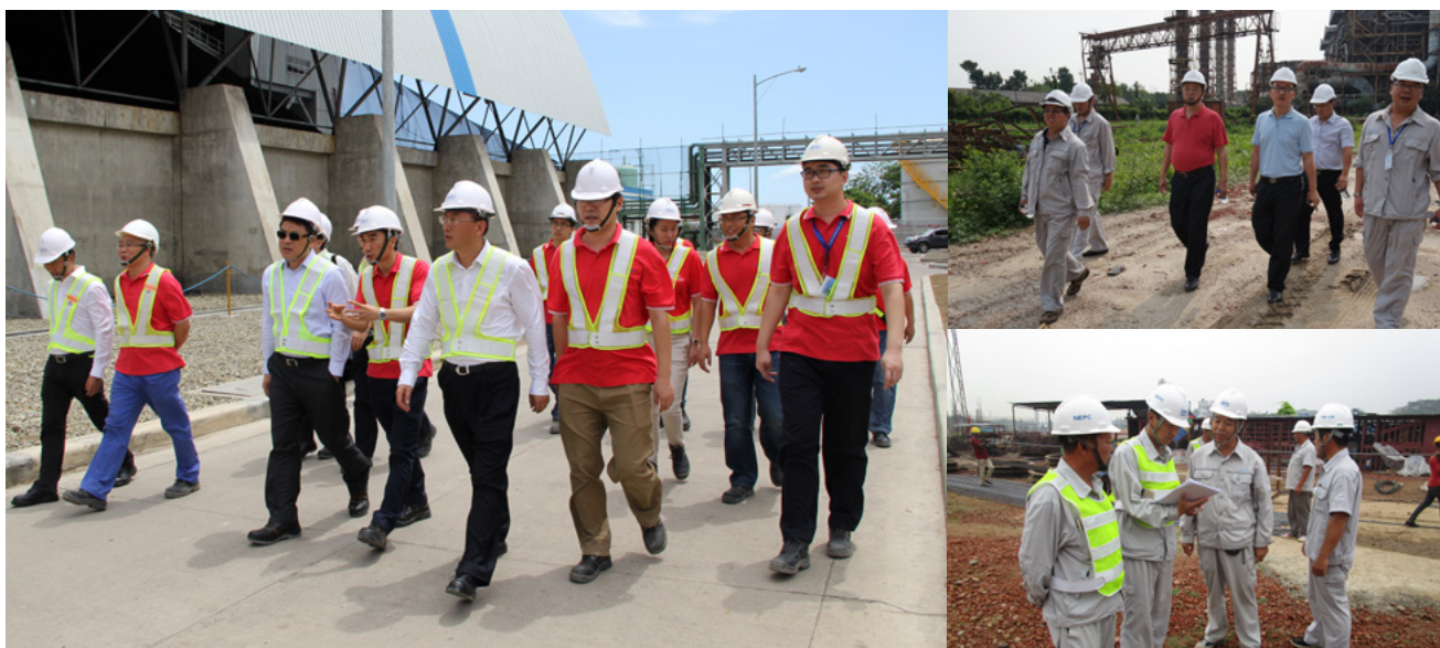
公司安全检查小组视察项目现场安全情况
