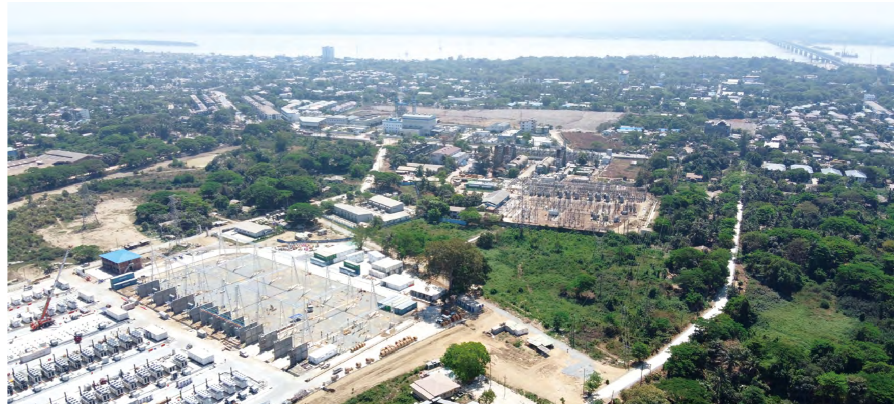
缅甸快速发电项目 The Fast Power Generation project in Myanmar
