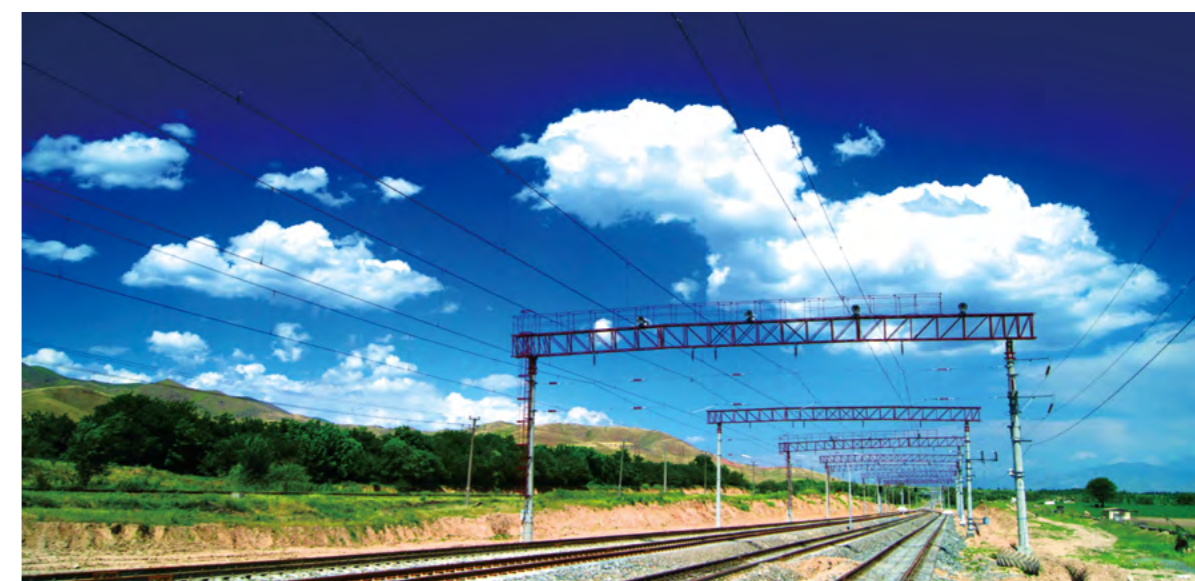
乌兹别克斯坦电气化铁路改造项目 The Railway Modernization Project in Uzbekistan
