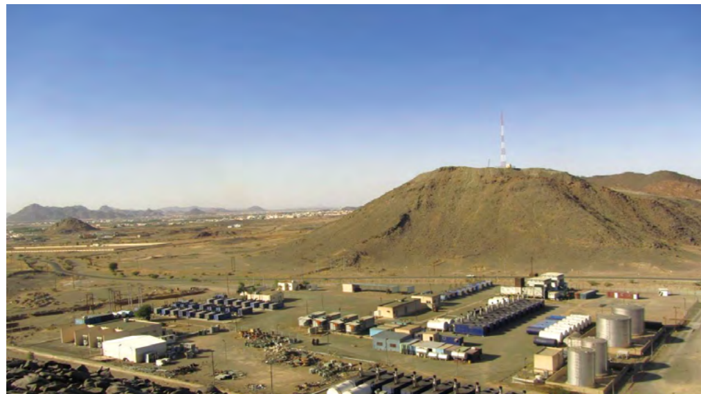
沙特 75MW 柴油机集群电站项目 The Saudi Arabian 75MW Diesel Engine Power Station Cluster project
